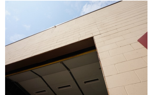
Overhead door lintel plate rust
